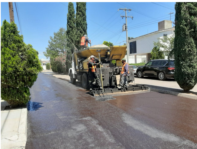
Aplicación de Slurry Seal .
